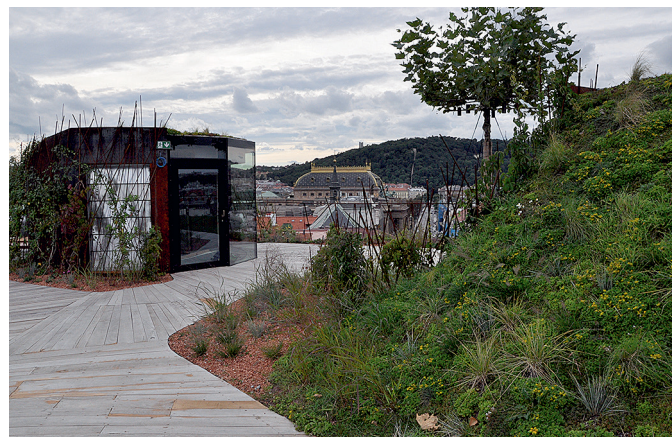
Výstupy na střechu kryté kobercem suchomilných rostlin; zdroj: Zahradní Architektura Kurz.
